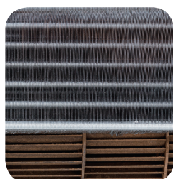
Sisäyksikön lämmönsiirrin 10 vuoden jälkeen ilman pinnoitusta.
